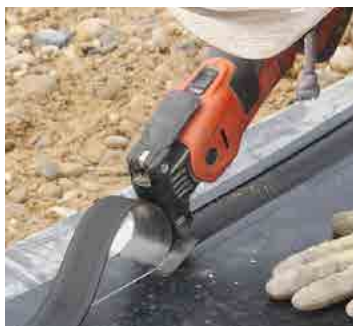
СНЯТИЕ СЛОЯ ПОКРЫТИЯ (ОБКЛАДКИ)
