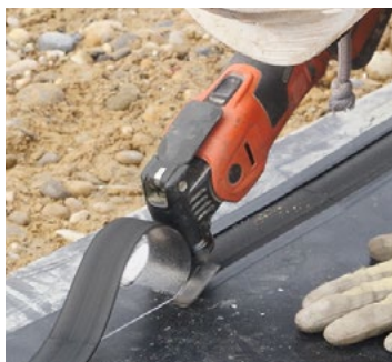
СНЯТИЕ СЛОЯ ПОКРЫТИЯ (ОБКЛАДКИ)
